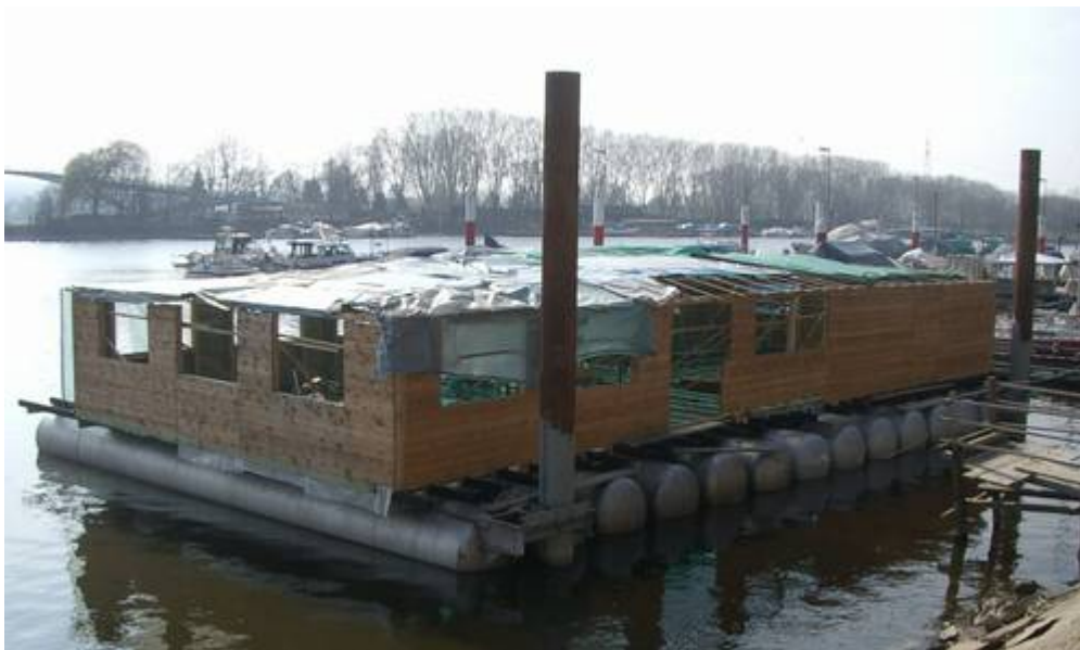
Bild 1: Blick nach Westen auf die schwimmende Bau ruine (Bild: LKG)
